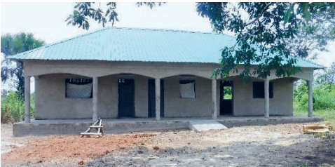
Der Erweiterungsbau Stand August 2020
